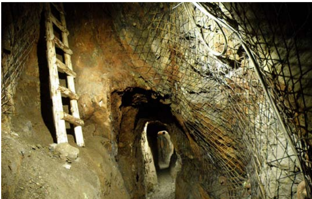
W niektórych miejscach stare wyrobisko wymagało założenia siatek MM.
